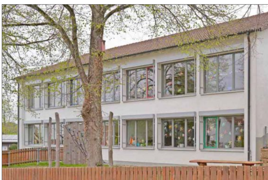
Um die Ganztagsbetreuung an der Grundschule Sölden umzusetzen, muss das Gebäude erweitert werden.
